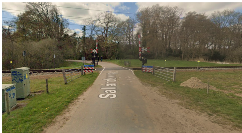
Afbeelding 2: bij sluiting van NABO-noord loopt de alternatieve wandelroute via de Sallandsweg, de verbindingsweg tussen dorp Diepenveen en de N334. De aanwezige AHOB en de Sallandsweg zijn in de huidige situatie onveilig voor voetgangers en zullen moeten worden aangepast (foto Google Maps, april 2021).
