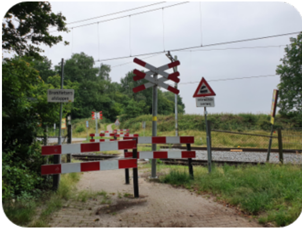
Afbeelding 6: aanzicht op de overweg vanaf De Gouden Ploeg, met zigzaghekken en dubbel Andreaskruis.
