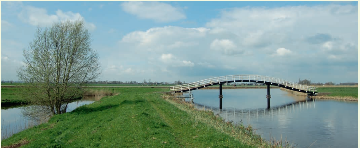
De nieuwe brug over de Dwarsgang, aan de overkant als een streep het nieuwe fietspad
